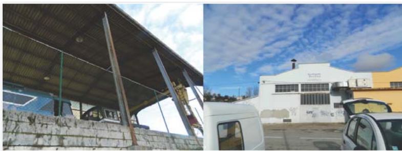
Hangar SCNF et Chaudronnerie Berlioz
